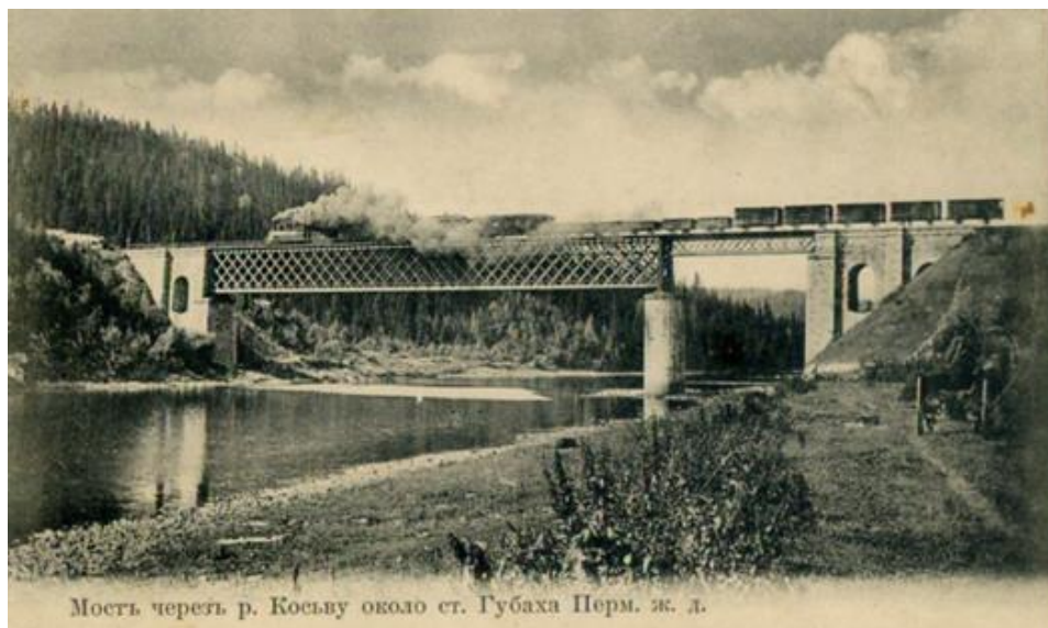
Рисунок 12 – Мост через р. Косью около ст. Губаха Пермской ж.д.
