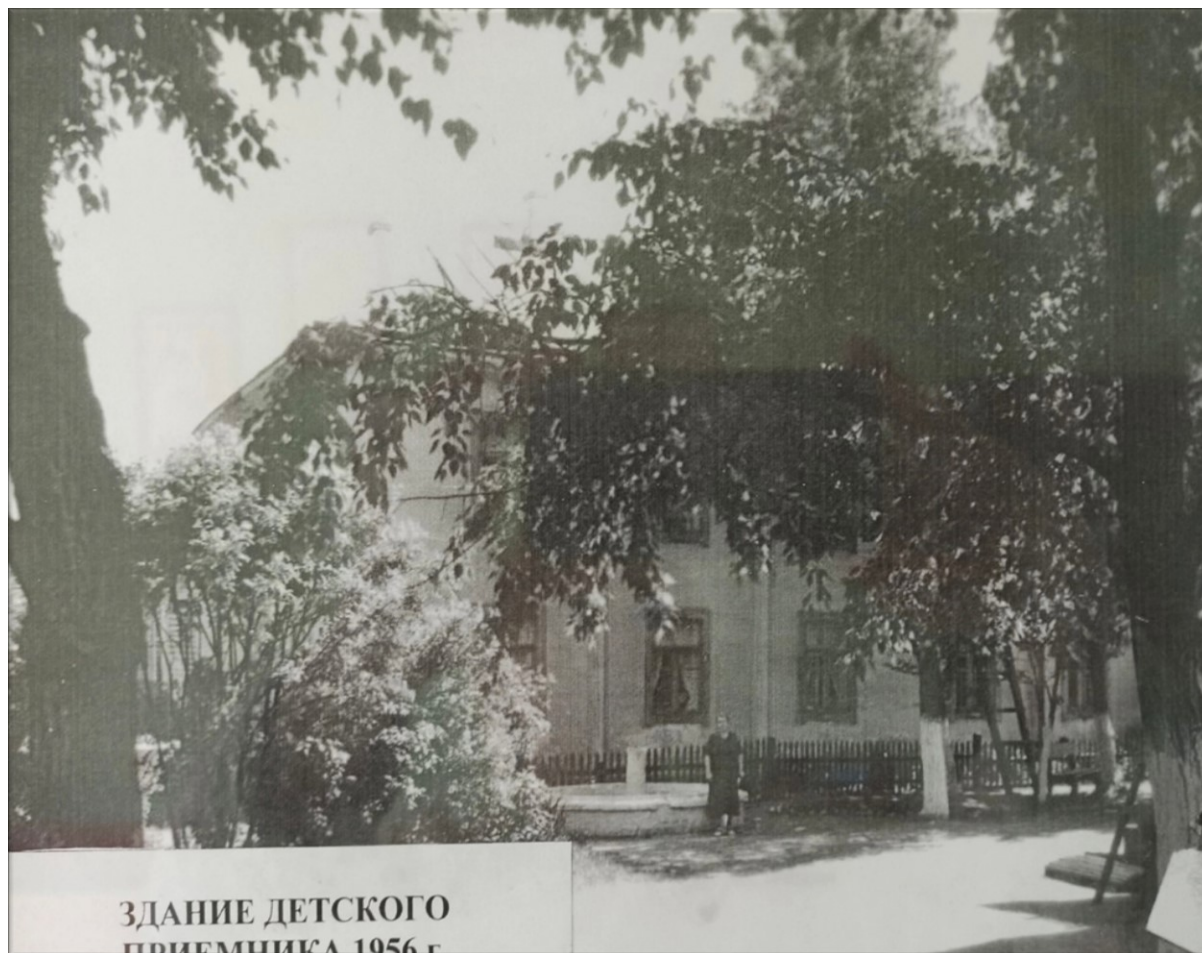
Рис. 1. Фотография «Здание детского приемника 1956 г.»
