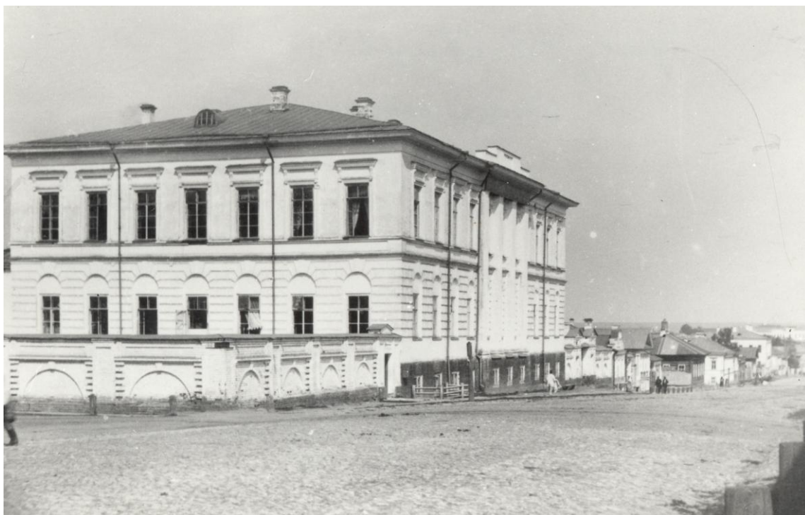
Рис. 2. Здание Пермского окружного суда
