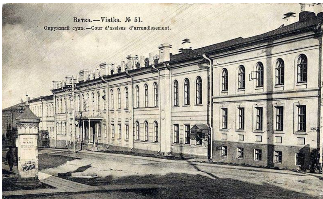
Рис. 1. Здание Вятского окружного суда
