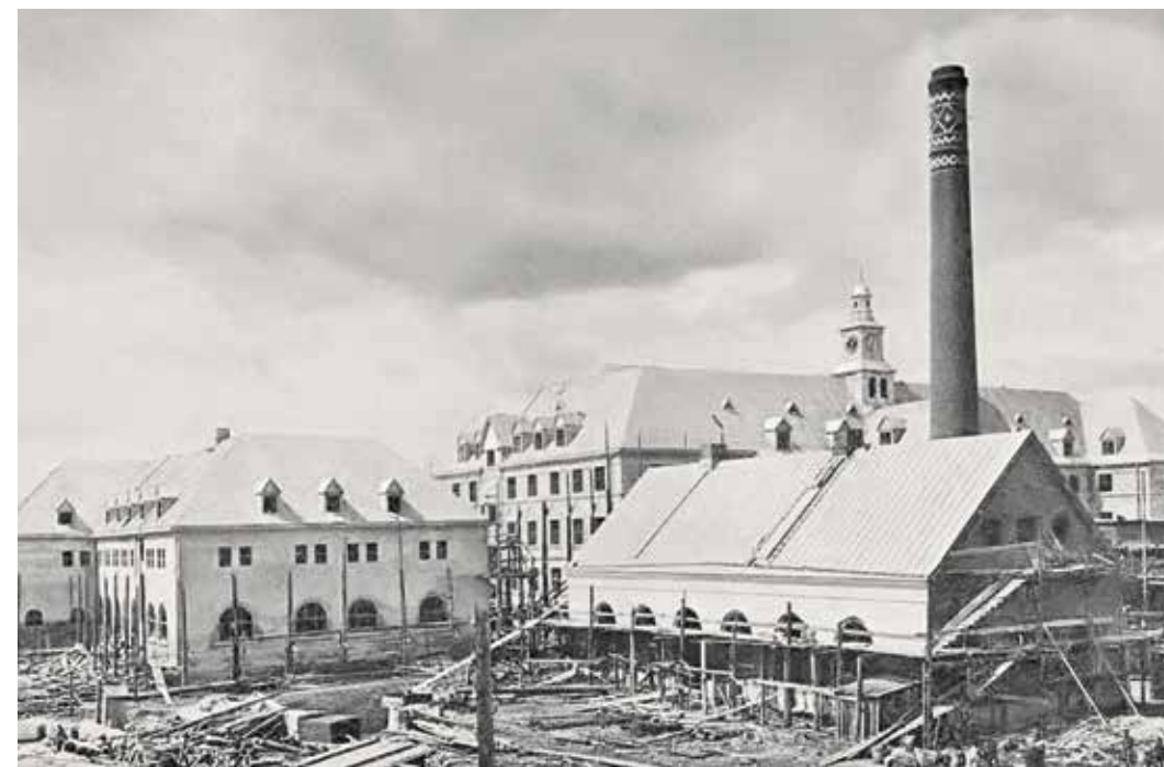
Комплекс зданий просветительских и благотворительных учреждений имени Е.И. Мешковой на Заимке. В 1916 г. переданы Пермскому университету
