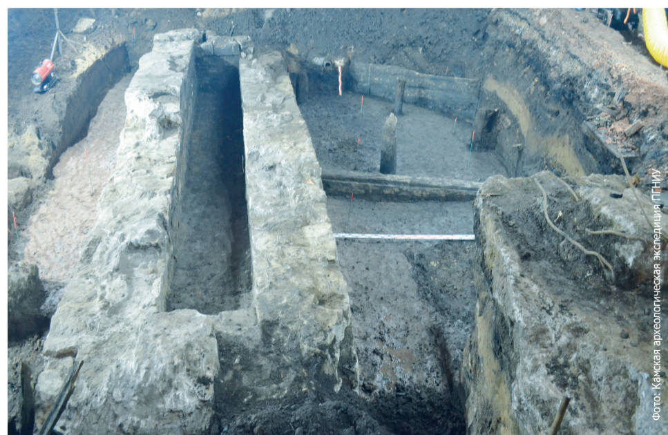
Одной из самых больших находок зимнего сезона стала 10-метровая смотровая яма для паровозов.
